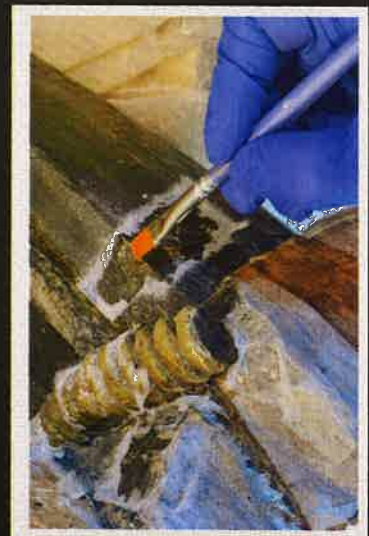
Pose d'un facing au pinceau
